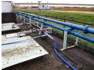
汲み上げた水を2工場と1工場に分岐
