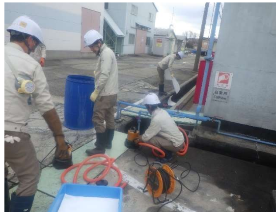
側溝にオイルキャッチャーを設置して漏洩防止する様子
