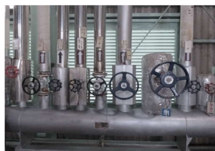
各方面への蒸気供給元バルブの様子
