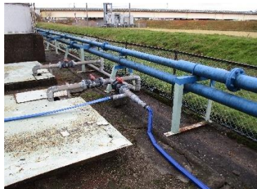
汲み上げた水を2工場と1工場に分岐
