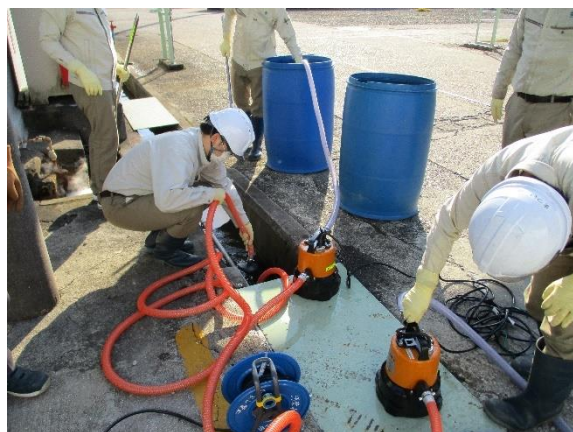
汚染水をポンプで汲み上げている様子
