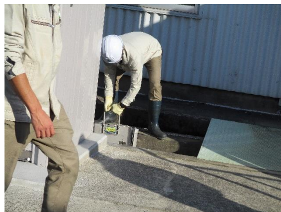
排水路に遮断板を使用して漏洩防止する様子
